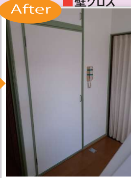
After ■壁クロス
